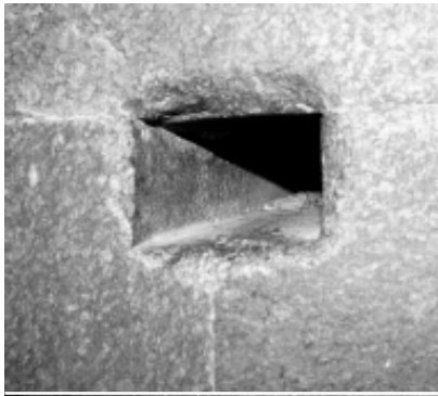
Unten: Der Zugangskorridor von der Großen Galerie in die Grabkammer der Cheops-Pyramide. Links: Die Öffnung des nördlichen Schachtes.
